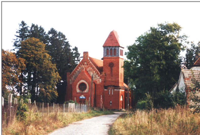
A. Pałowo - widok kościoła od strony zachodniej. Fot. W. Florek, 19.09.2002
